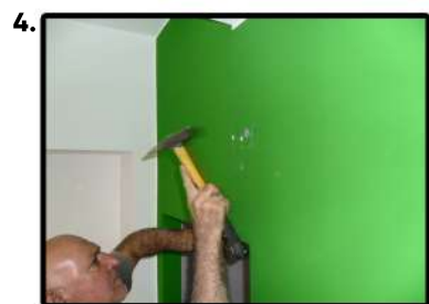
4. Dopo aver inserito tutti i tasselli nel muro, poggiare il carrello ed avvitare saldamente al muro.
