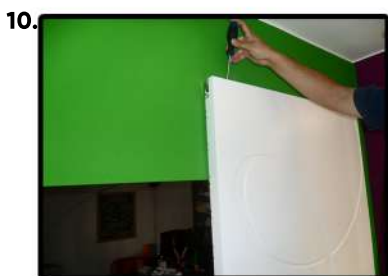
10. Inserire la sicurezza, per evitare che il pannello si sganci..
