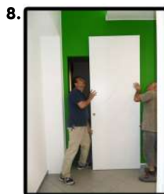
8. Agganciare la porta a vetri sulla guida in alluminio. Stringere con una chiave esagonale la vite a brugola posta sulla ruota.
