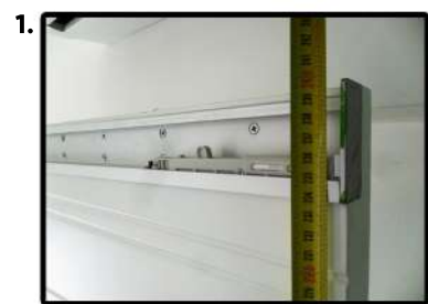
1. Misurare l'attacco del binario in alluminio fissato sul pannello porta.
