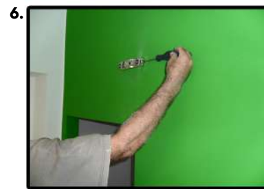
6. Questa vite di regolazione serve per alzare o abbassare il pannello porta.
