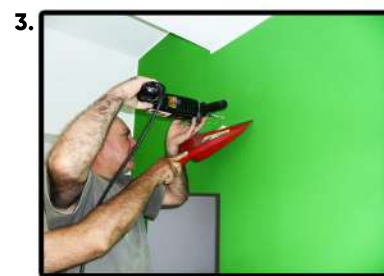
3. Segnati i fori eseguire la foratura con una punta per muro del diametro da mm. 8 e per mm. 40.
