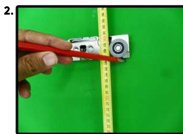
2. Rispetto alla misura del binario del pannello porta, posizionare il carrello cm. 3 più alto e segnare i fori di fissaggio. segnare nel muro la base del carrello.
